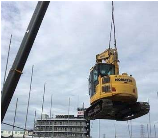
写真5 小型解体重機の揚重イメージ
