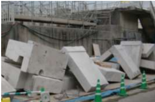
写真3 ブロック解体の解体後のイメージ
