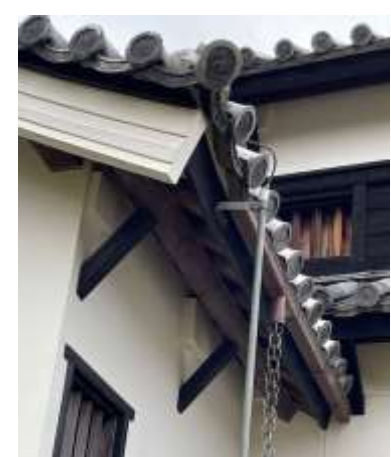
福岡城多門櫓 出桁と方杖
