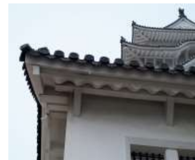
姫路城備前門 出桁と方杖
