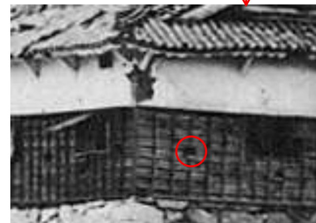
「広島城裏御門周辺」(部分) 大阪公立大学都市科学・防災研究センター所蔵 明治 5 年(1872)以前の撮影か、 北東隅櫓の下見板の外部に露出した狭間が確認できる
