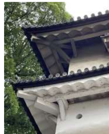
岡山城西手櫓 出桁と方杖
