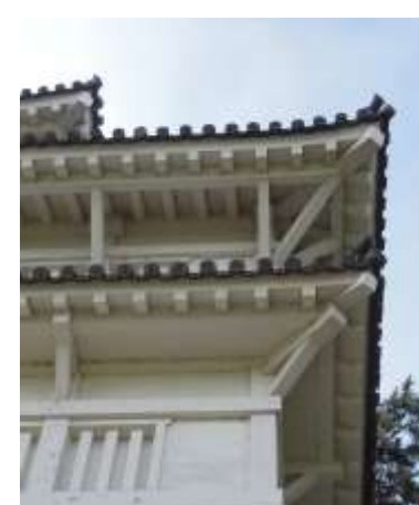
岡山城西手櫓 出桁と方杖
